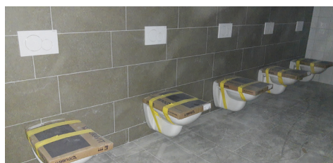
De toiletten, douches en wasbakken werden op hun plaats gehangen.
