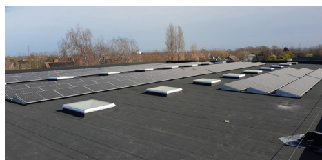
De zonnepanelen werden bevestigd.
