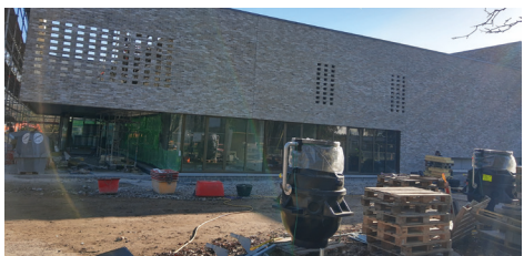
De buitenmuren zijn opgemetsd. De stellingen worden weggehaald van de muren die reeds opgevoegd werden.
