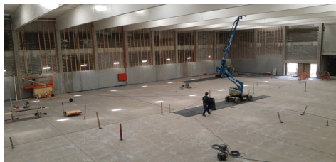
De chape in de sporthal werd gegoten.
