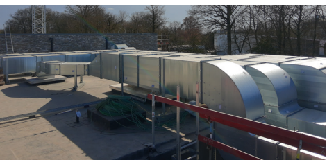
De onderdelen voor het ventilatiesysteem werden op het dak geplaatst.
