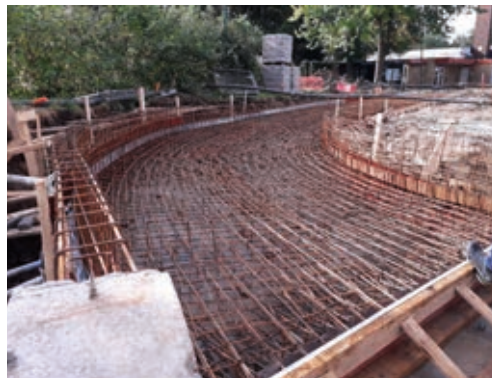
De bewapening voor het hellend vlak richting de buitenkleedkamers en de nooduitgang van de sporthal zijn klaar. De bijkomende muren aan de zijkant zijn voorzien omwille van de hoge grondwaterstand.
