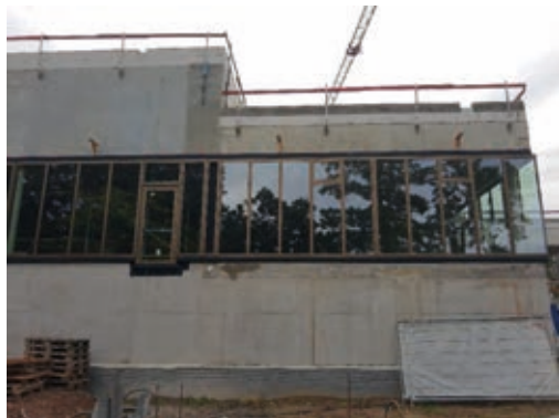
Het buitenschrijnwerk van het zwembad werd geplaatst.
