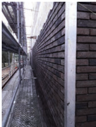
Er is gestart met het metsen van de buitensteen van het nieuwe sportcentrum. Deze werken duren tot eind 2021.
