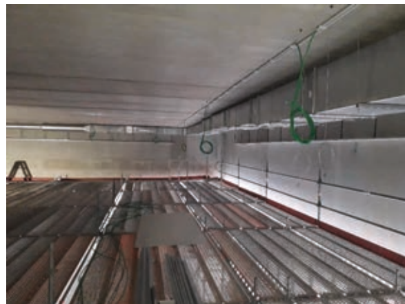
De voorbereidende werken voor het plafond van het zwembad schieten goed op. Op de foto: de lucht- en ventilatiekanalen en de elektriciteit die boven het akoestisch plafond worden geplaatst.
