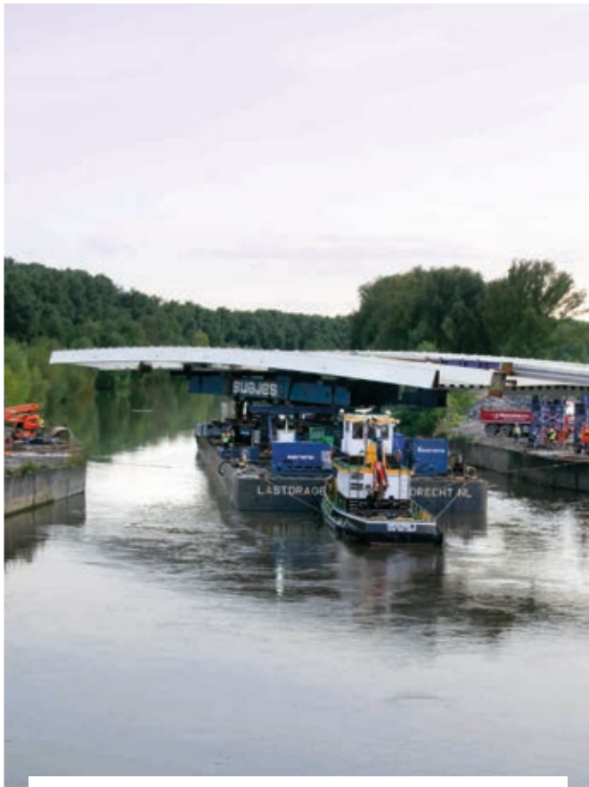
BRUGDEK BRUG OOIGEM - DESSELGEM INGEVAREN
